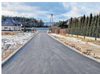
Rozbudowa i modernizacja dróg gminnych
