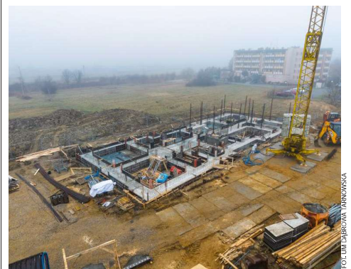
Planowany termin zakończenia budowy przewidziany jest na drugą połowę 2027 roku
