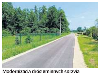
Modernizacja dróg gminnych sprzyja bezpieczeństwu pieszych i kierowców
